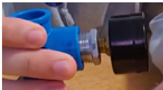
Figura 1: "T" azul + redução + manômetro
